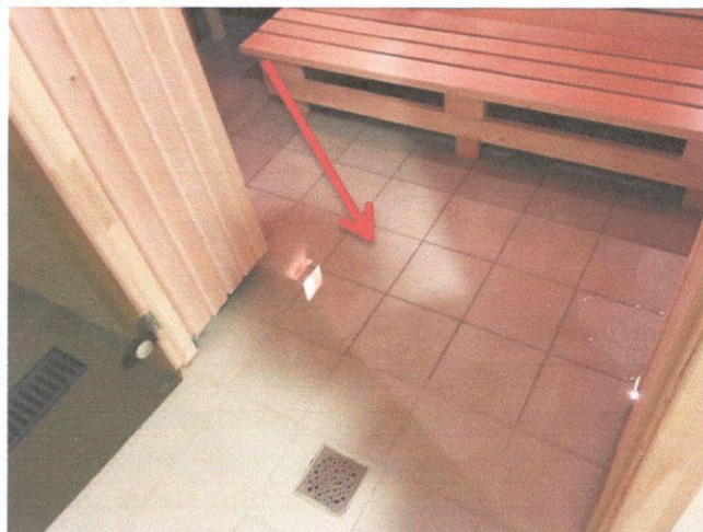
Foto nr.16 Karsētavā nav izveidota ūdens novadīšana.
