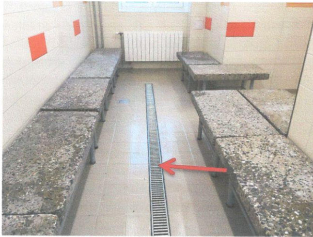
Foto nr.9 Papildus izbūvēts garais traps būvd.gar. laikā.
