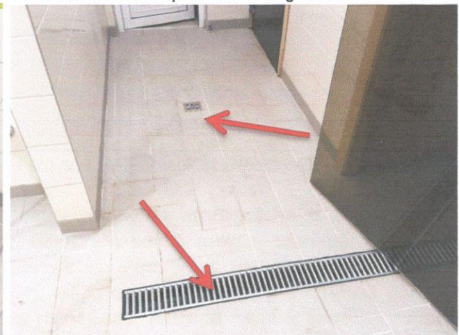
Foto nr.4 Papildus trapi pie pērtuvēm, izbūvēti būvdarbu garantijas laikā.
