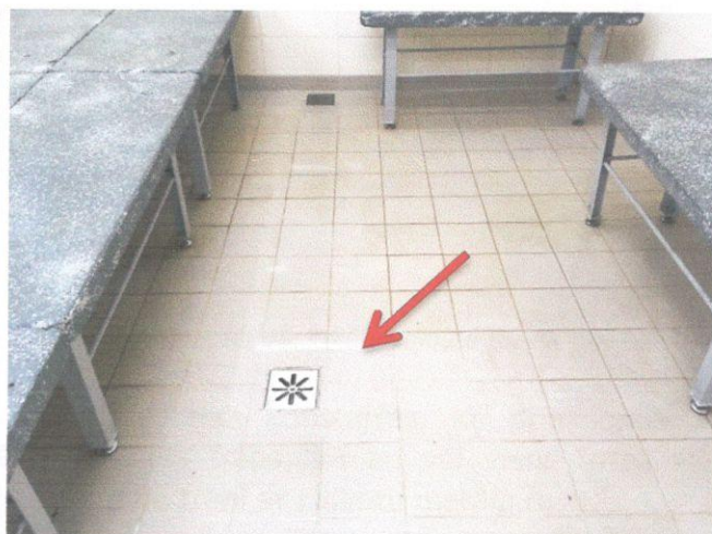
Foto nr.8 Mazgāt. apkārt trapam paliek ūdens peļķes.
