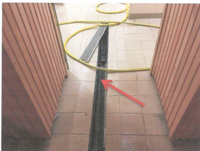
Foto nr.17 Būvuzņēmēja pašrocīgi izbūvētais traps, kurš savieno mazgātuvī ar pērtuvi. Foto nr.18 Sprauga 5cm. zem pērtuves durvīm.
