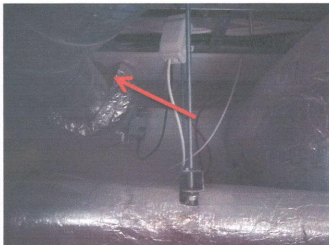
Foto nr. 28 Noizolēts tikai ieņemšanas vārsts.
