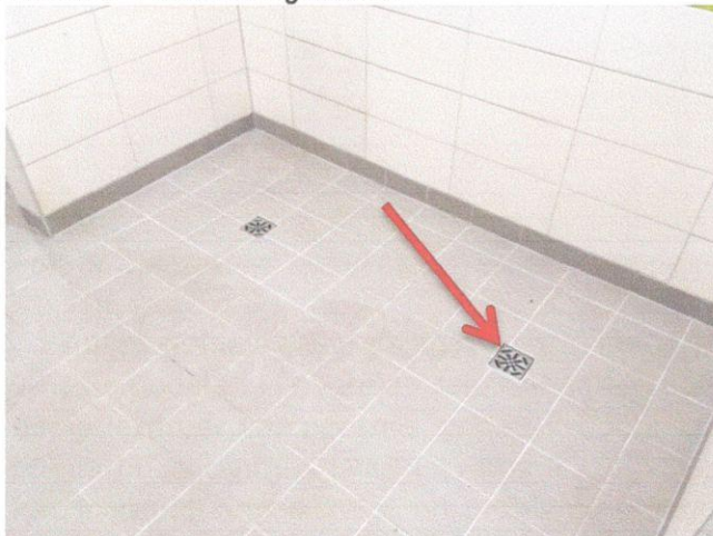
Foto nr.3 Būvniecības realizācijas laikā papildus izbūvēta dušas vieta.
