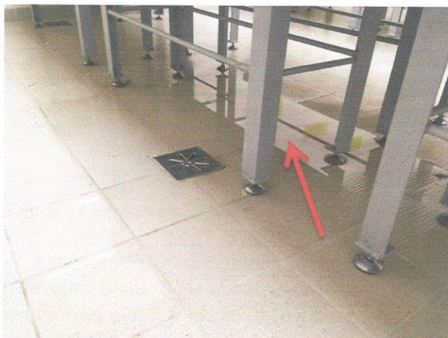
Foto nr.7 Mazgātuvē apkārt trapam paliek ūdens peļķes.
