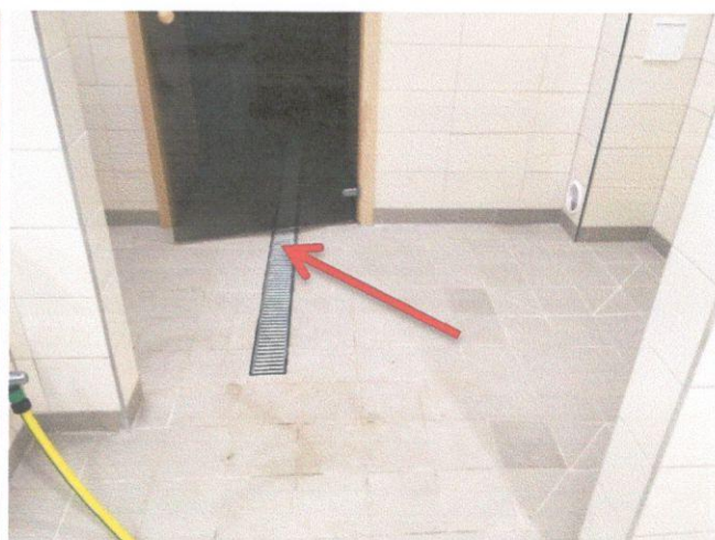
Foto nr.17 Būvuzņēmēja pašrocīgi izbūvētais traps, kurš savieno mazgātuvī ar pērtuvi. Foto nr.18 Sprauga 5cm. zem pērtuves durvīm.
